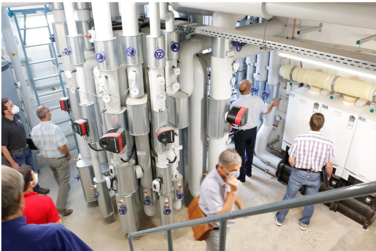
**Foto © INEV:** Besichtigung der Heizungsanlagen im Schulkomplex der Grund- und Mittelschule Siegsdorf. Die Heizwärmeverteilung im Schulkomplex übernimmt ein sogenannter Zortström-Heizverteiler. Die Teilnehmer waren von dem interessanten Aufbau der Anlage und der sauber ausgeführten Arbeit sichtlich beeindruckt.
